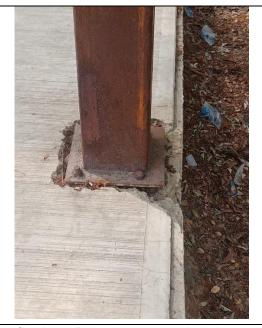
Fotografía No. 7. Base de concreto de columna de estructura metálico con continuo en la base, y con la tornillería del perfil metálico instalado de manera asimétrica respecto a lo descrito en planos.
