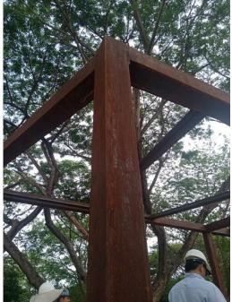
Fotografía No. 1. Vista general de la estructura metálica portal de sombras del ítem 3.04.01, no tiene la pintura de protección de acuerdo con las especificaciones del ítem, se evidencia corrosión en la estructura existente.
