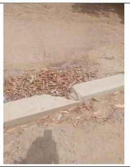
Fotografía No. 8. Detalle de bordillo de la 5.03.01 prefabricado, con impacto mecánico y desportillamiento.
